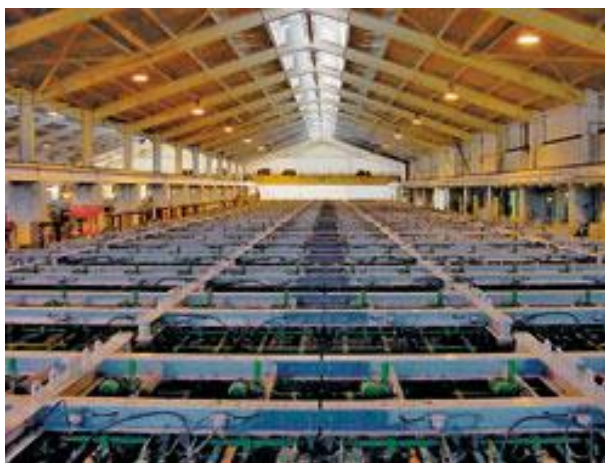
Рис. 6.30. Ртутные электролизёры.
